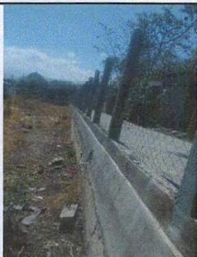
Foto 1: REPARACION DE MURO PERIMETRAL EN MAL ESTADO, POR MALA GALVANIZADA DE 3".
