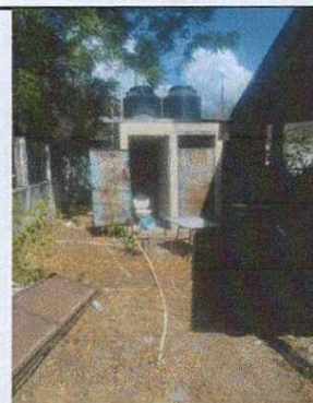
Foto 4: REPARACION EN AREA DE BAÑOS
