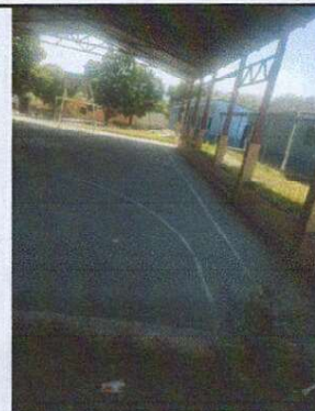
Foto 2: SUSTITUCION DE MURO DE CONTENCIÓN EN AREA DE CANCHA
