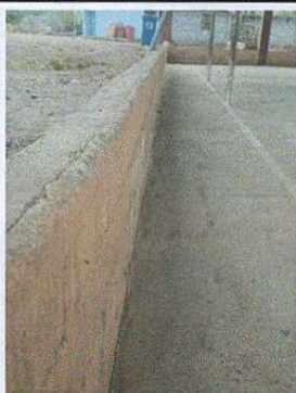
Foto 3: REFUERZO Y REPARACIÓN DE MURO DE CONTENCIÓN.
